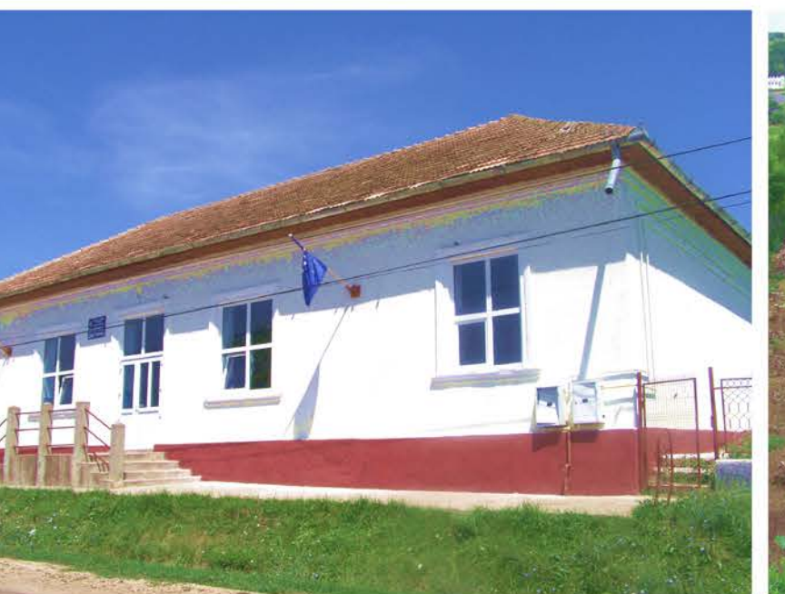
REPARAȚII CĂMIN CULTURAL
