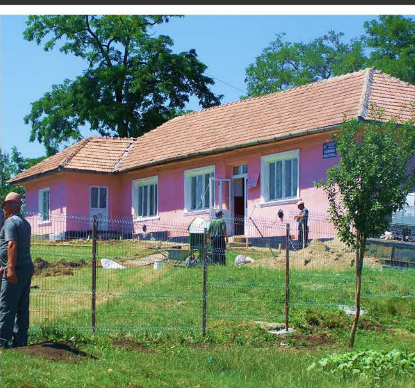
REPARAȚII CĂMIN CULTURAL
