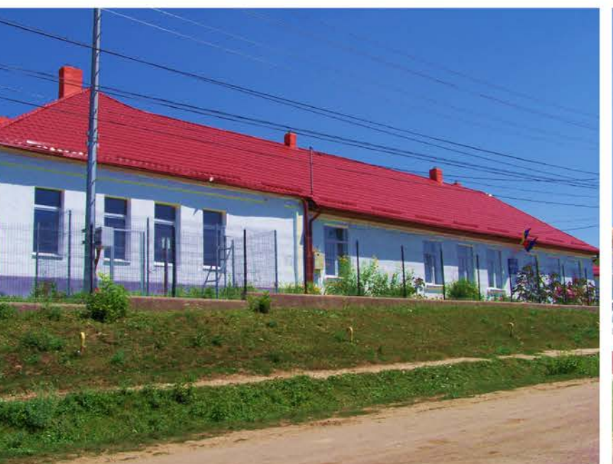
REPARAȚII ȘI MODERNIZARE - ȘCOALĂ
