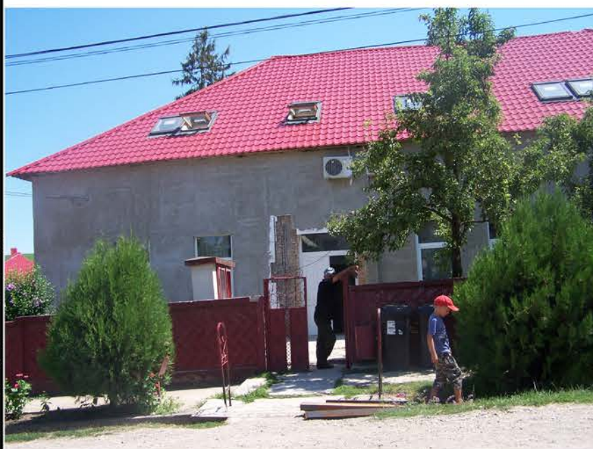
REPARAȚII ȘI MANSARDARE PRIMĂRIE
